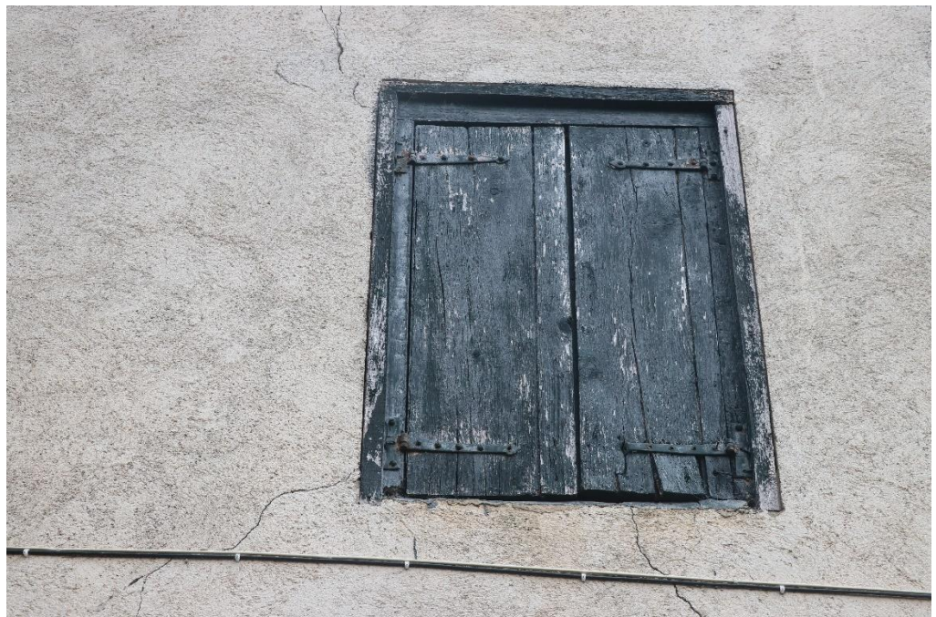
Figure 26 : Baie à cadre de charpente et volets en bois, premier étage du mas de la Serrada (rue de la Torre)
