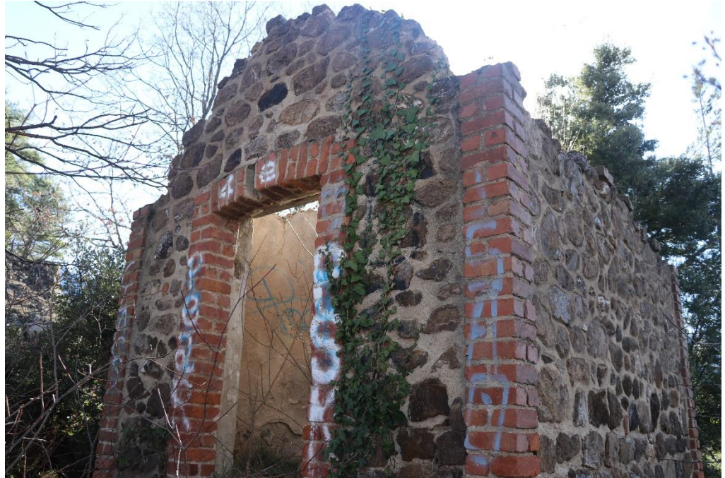
Figure 42 : Vue Nord-Est de la maison du treuil, (OA 188)
