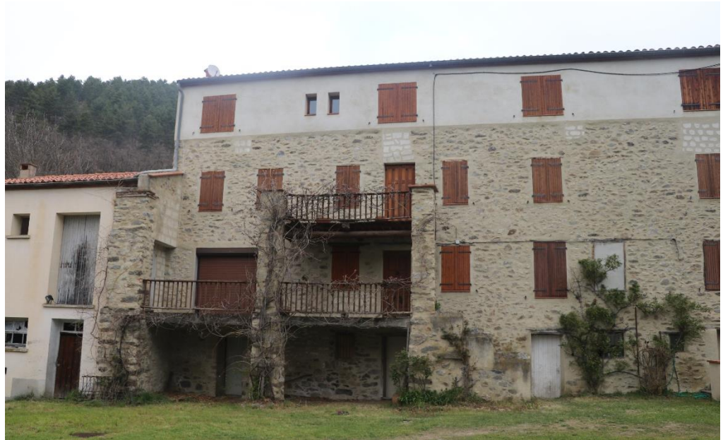
Figure 37 : Façade principale (Sud) du mas d'Avall
