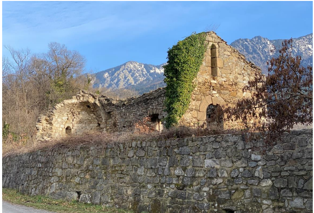
Figure 3 : Vue d'ensemble de l'église Saint-Pierre ruinée
