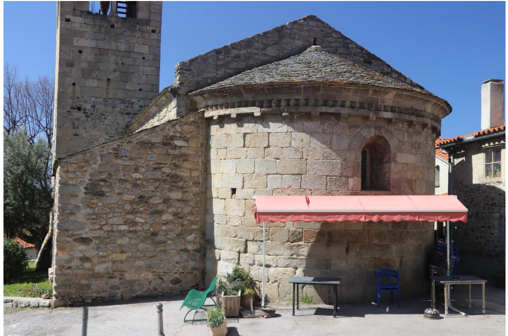
Annexe 8 : Parement en leucogranite, abside de l'église Saint-Félix
