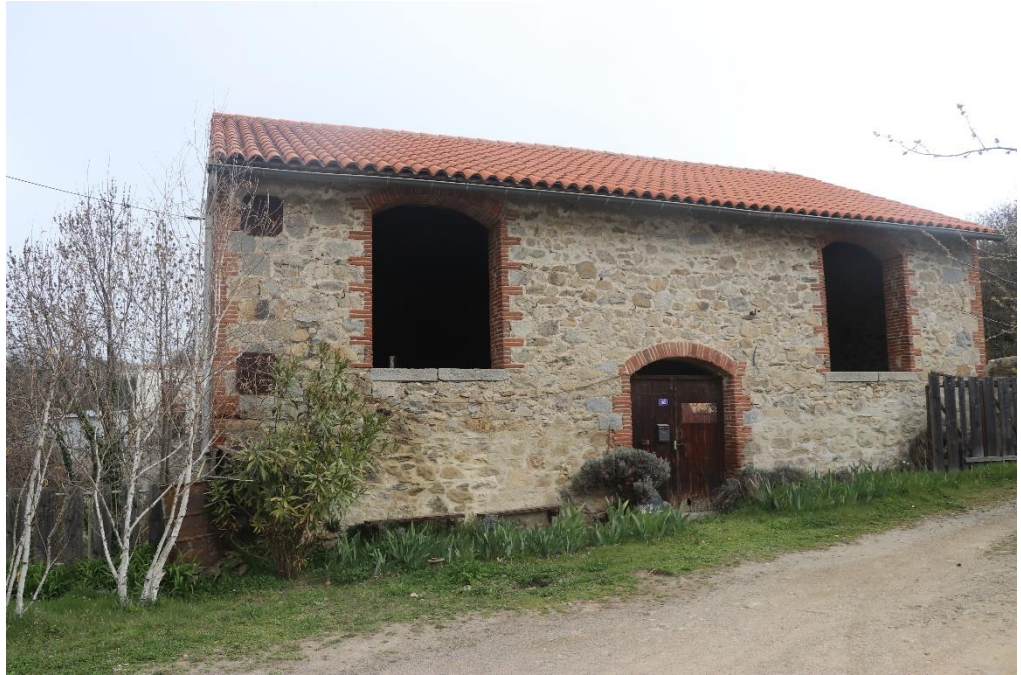
Annexe 10 : Grange-étable avec maçonnerie « à pierres vues », mas dit de « la Tour »
